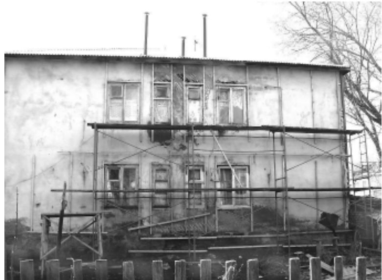
На снимке: вместо того, чтобы пустить ветхое жилье на слом, на гнилые стены домов, по указанию В. Рогожкина, прикрепили металлические листы.
